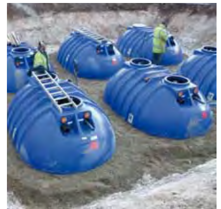
Praxisbeispiele: Großanlagen mit mehreren BlueLine II Erdtanks a 10.000 Liter.
