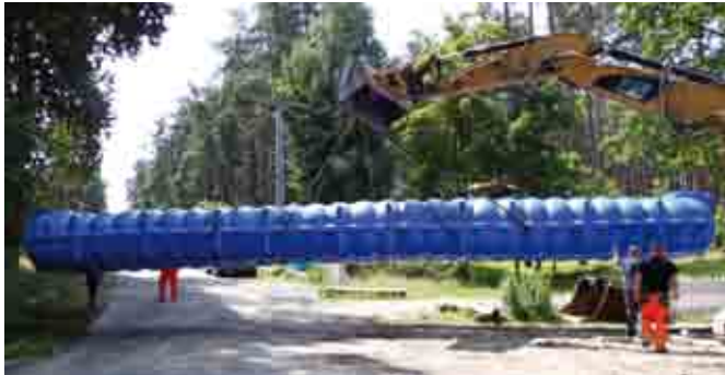
Einfacher Einbau durch geringe Einbautiefe (Höhe Tankkörper nur 126 cm)
