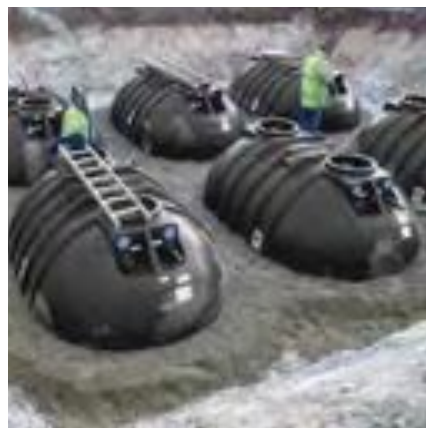
Praxisbeispiele: Großanlagen mit mehreren BlueLine II Erdtanks a 10.000 Liter.
