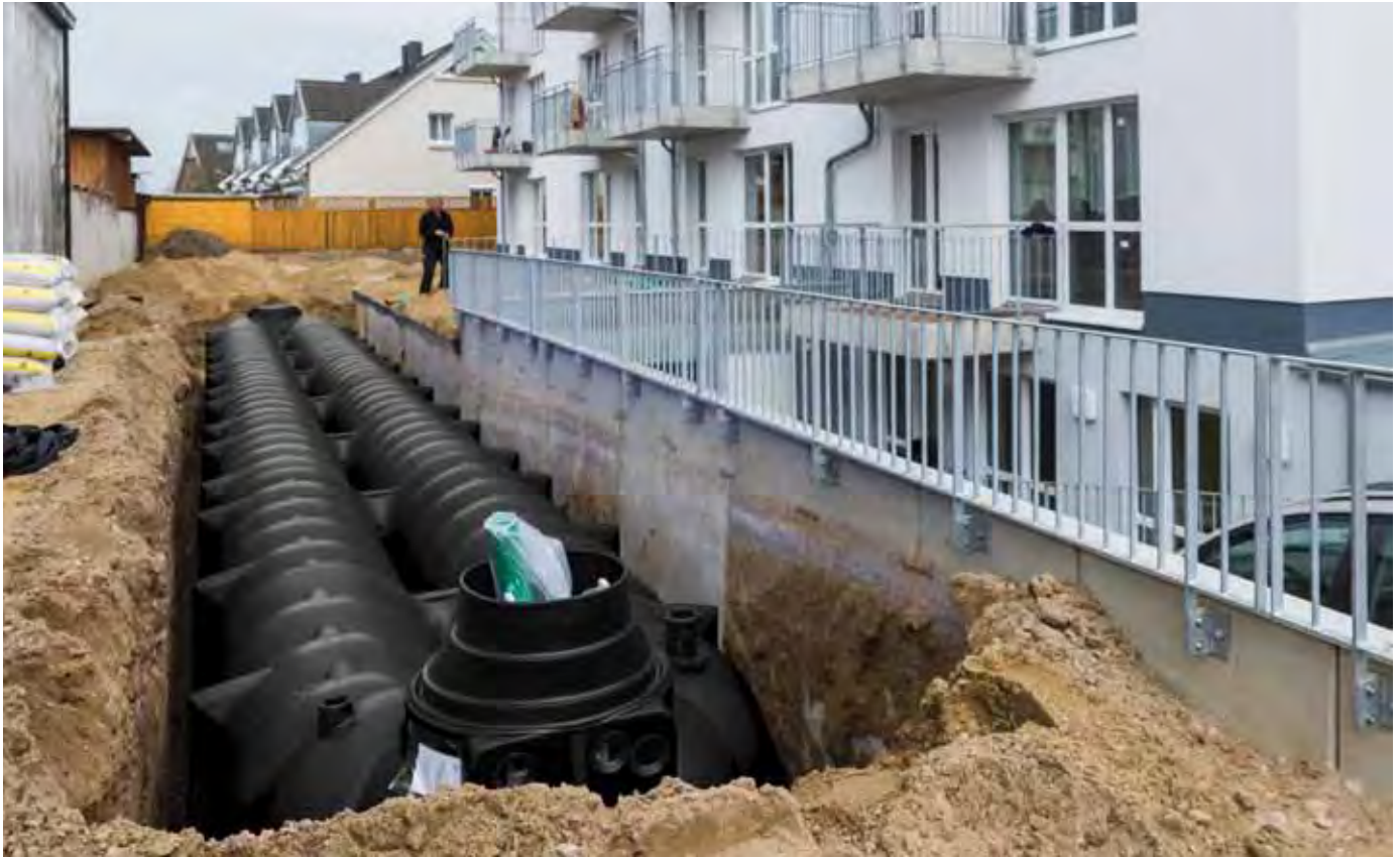
Praxisbeispiel: Einbau NEOplus Löschwassertank 40.000 Liter im eng bebauten Wohngebiet
